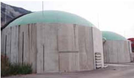
Tanks für flüssigen Fermentationsrückstand
